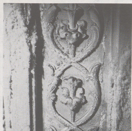
Abb. 9 Zerstörung der Stukkaturen in der Kuppel durch Ausblühungen
