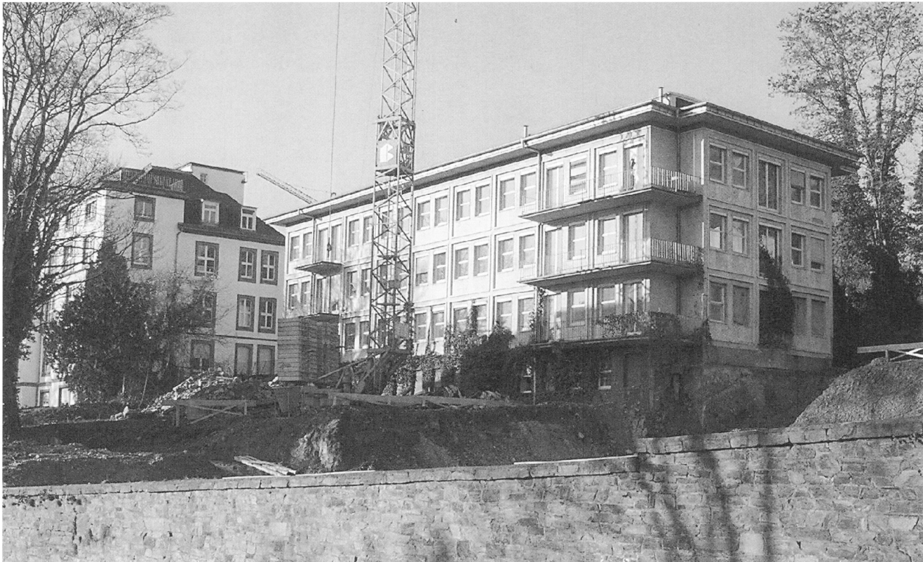
Die Gebäude Leberberg 9 und 11 wurden von den Architekten Niessen/Schaeffer-Heyrothsberge umgebaut bzw. neu errichtet. Foto: Bildarchiv MATTIACA
