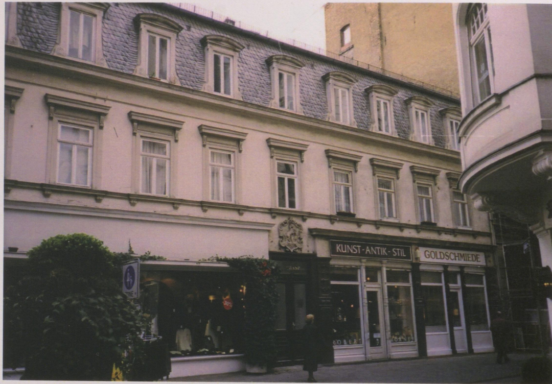
Blick aus der Häfnergasse auf das im Kern noch dem ausgehenden 18. Jahrhundert entstammende Gebäude Goldgasse Nr.2
