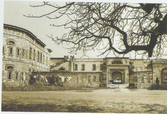
Bild 7. Blick vom Rheinufer auf das Westportal vor der Wiederherstellung des Satteldachs
