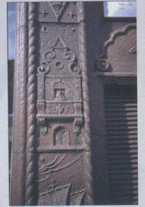
Bild 5. Plastische Details der restaurierten Keramikfassade
