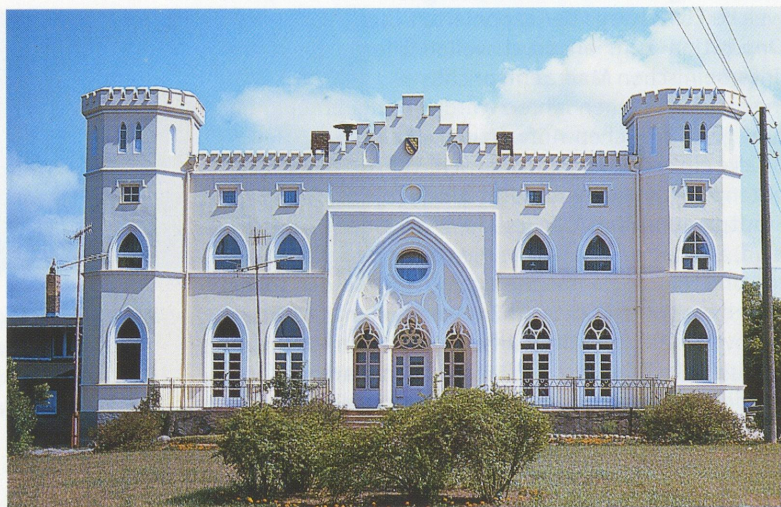
Bild 1. Gutshäuser und Schlösser in Mecklenburg gilt es zu erhalten. Dafür eignen sich Silikat- und Siliconharz-Fassadenfarben. Schloss Granskewitz auf Rügen ist mit Amphisilan-Fassadenfarbe gestrichen
