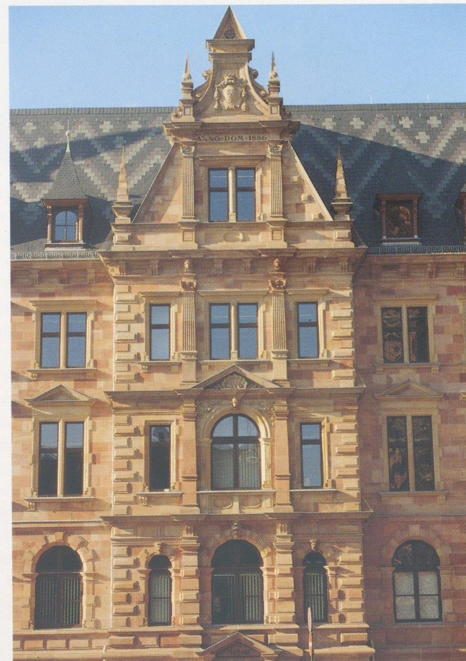
Das Mittelrisalit der Ostfassade des Rathauses
